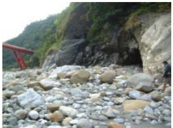
圖 88. H 區後岩壁較碎，不建議攀登 後方為長春隧道引橋
